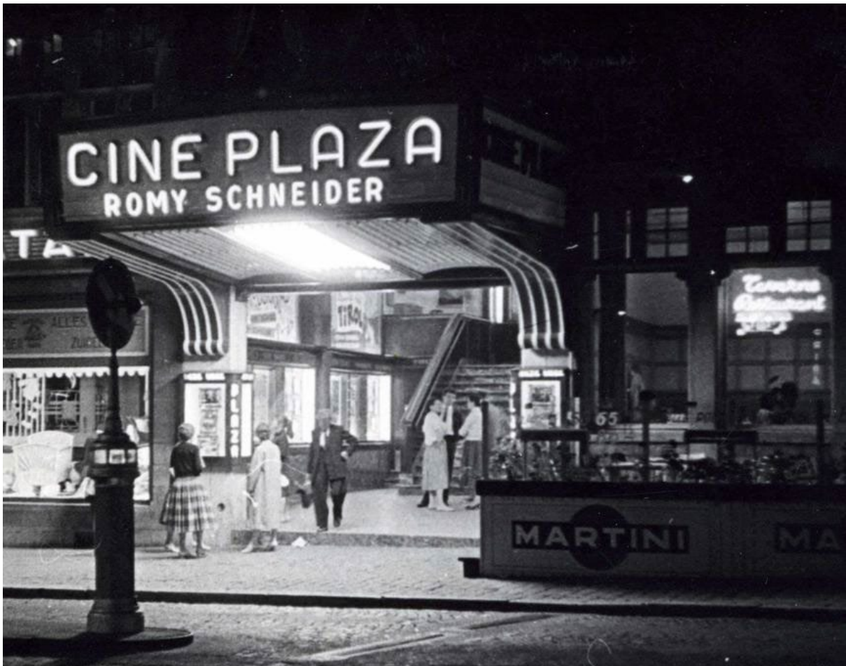
Fig. 22 : Zicht op het inkomportaal met nieuwe luifel, loketten en open centrale trap tot op het bordes (Gent, Privé-archief Sphinx Production)
