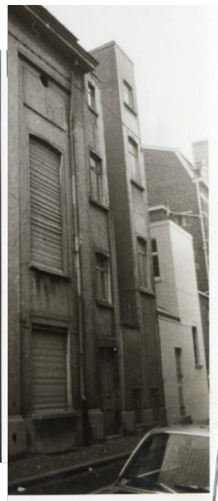
Fig. 26 : Foto's van de gevel aan de Jan Van Stopenberghestraat uit de jaren 1970 voor de verbouwing van 1977 (Gent, SA & Mar Jaen)
